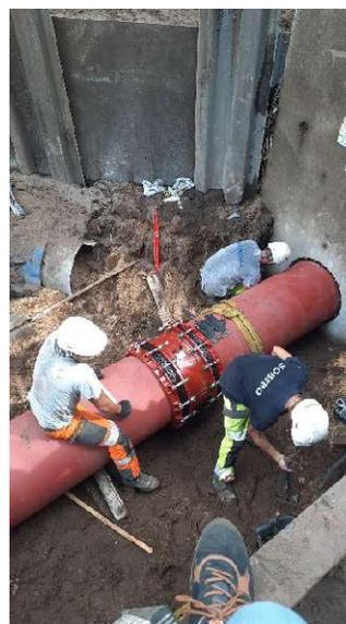
Réalisation assemblage Té-allonge-vanne et ventouse
