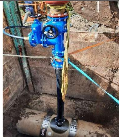
Réalisation assemblage Té-allonge-vanne et ventouse
