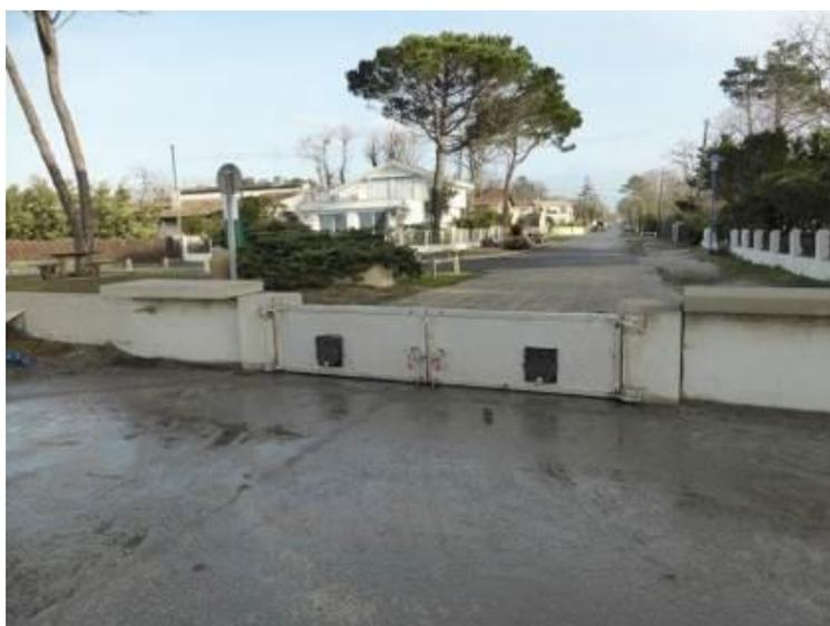
Figure 97 : ALB – PORT7 avec vantaux fermés (source : SIBA)
