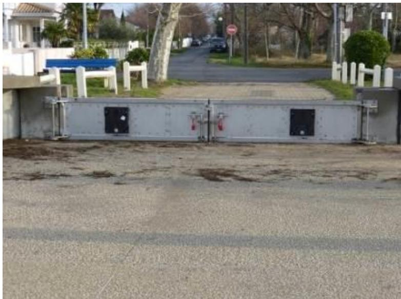
Figure 68 : ALB-PORT3 avec vantaux fermés (source : SIBA)
