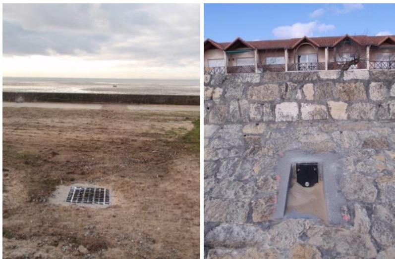
**Figure 12 : avaloir entre les deux ouvrages de protection et barbacane à travers l'ouvrage de protection de 1<sup>er</sup> rang**
