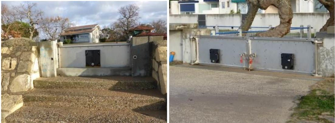
**Figure 11 : batardeau et porte sur les ouvrages de protection du système d'endiguement (source : SIBA)**
