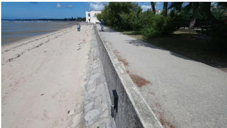
**Figure 133 : état du parement amont de l'ouvrage de protection de 1<sup>er</sup> rang**
