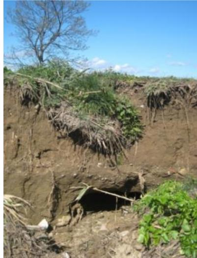
**Figure 194 : digues de l'Agly – Erosion de talus et débouché du fontis (source : ISL)**
