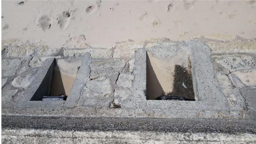
Figure 115 : barbacanes avec clapets anti-retour (05/09/2019 ; source : ISL)
