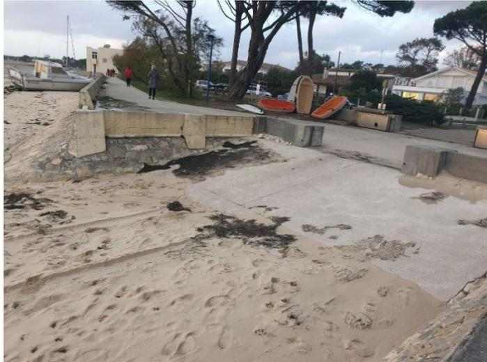
**Figure 145 : post tempête Amélie à la jonction entre le tronçon n°3 et le tronçon n°4**
