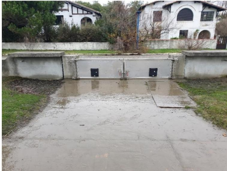
Figure 126 : ALB – PORT11 avec vantaux fermés (source : SIBA)
