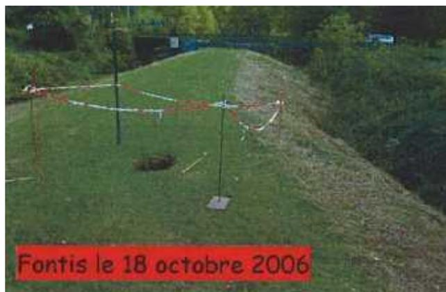
**Figure 196 : fontis dans la digue de la station INRA de Saint Pée sur Nivelles (source : ISL)**
