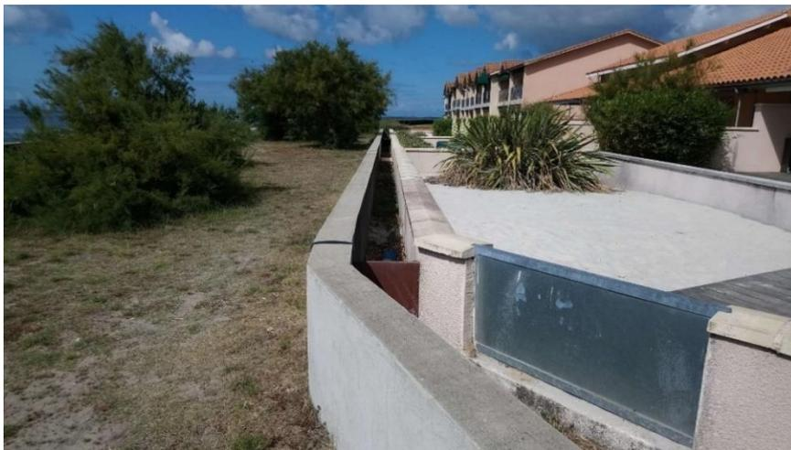
**Figure 62 : ouvrage de protection de 2<sup>nd</sup> rang en amont immédiat des résidences (05/09/2019 ; source : ISL)**
