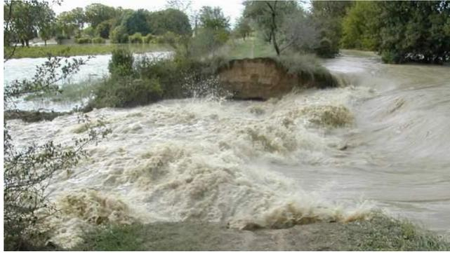
**Figure 190 : rupture de digue par surverse du Vidourle à Marsillargues lors de la crue de septembre 2002 (source : mairie de Marsillargues)**
