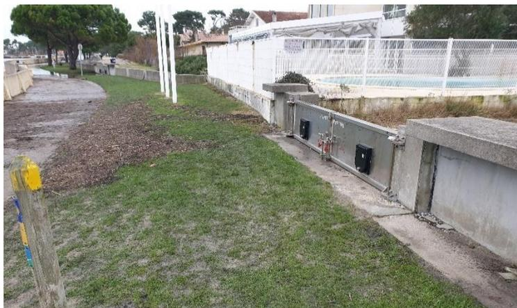
Figure 122 : ALB – PORT9 avec vantaux fermés (source : SIBA)
