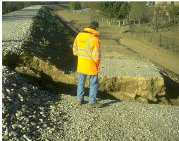
**Figure 195 : renard le long d'une conduite sur la digue de Cuxac-d'Aude lors de la crue de novembre 1999 (source : IRSTEA), ayant occasionné un écoulement de plusieurs centaines de litres secondes à travers la digue - brèche en cours de formation**
