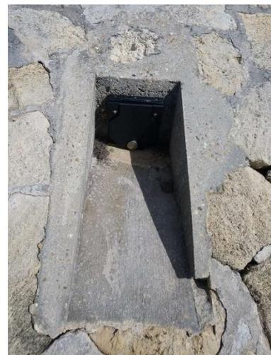
**Figure 58 : exemples de clapets anti-retour sur l'ouvrage de protection de 1<sup>er</sup> rang (05/09/2019 ;
