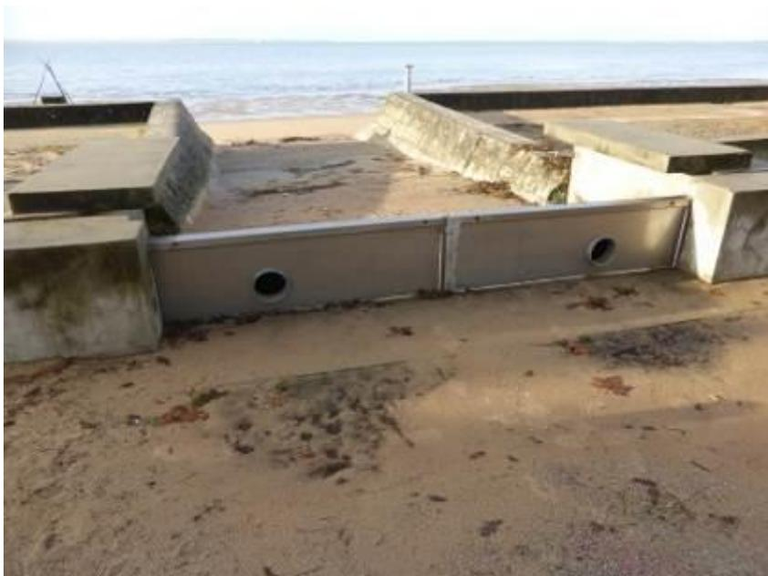
**Figure 64 : ALB-PORT1 avec vantaux fermés (source : SIBA)**
