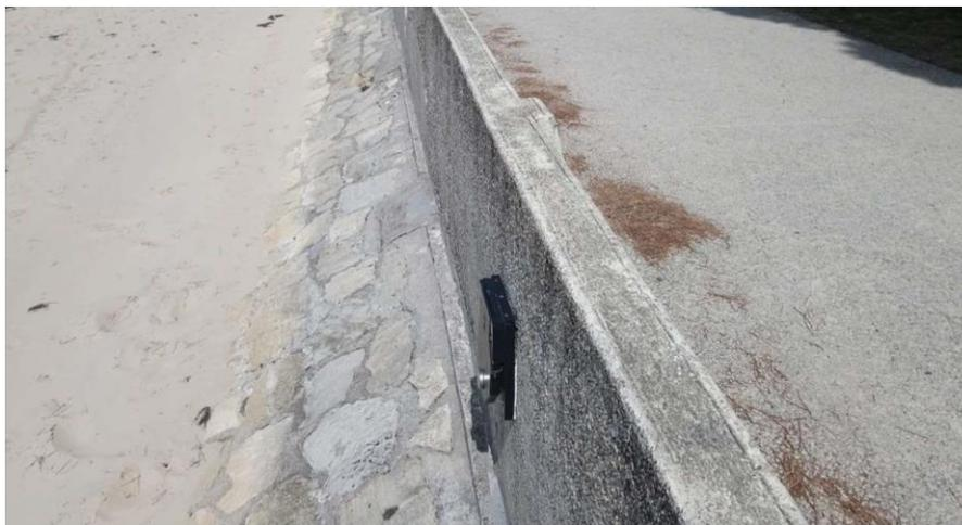
Figure 116 : clapet anti-retour sur le parapet (05/09/2019 ; source : ISL)
