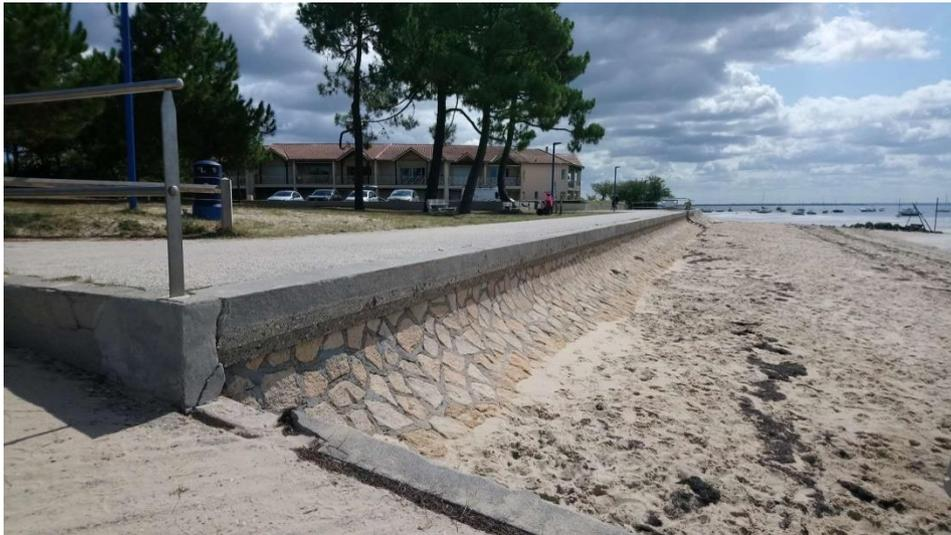
**Figure 74 : ouvrage de protection de 1er rang (05/09/2019 ; source : ISL)**
