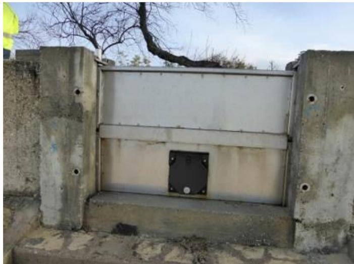
**Figure 112 : exemple de batardeau installé sur un escalier**
