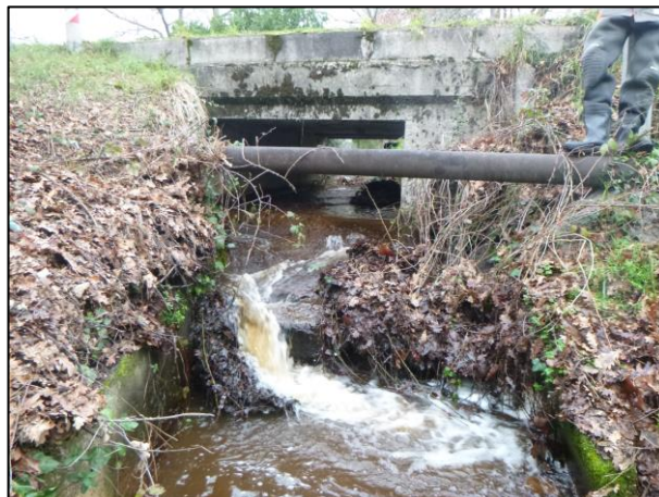
Photo 5 : Déchaussement du radier béton sur le Bétey amont
