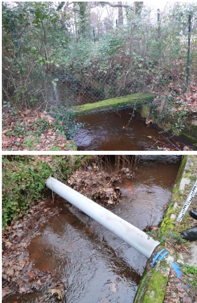
Photo 4 : Exemples d'éléments en travers : clôture et conduite
