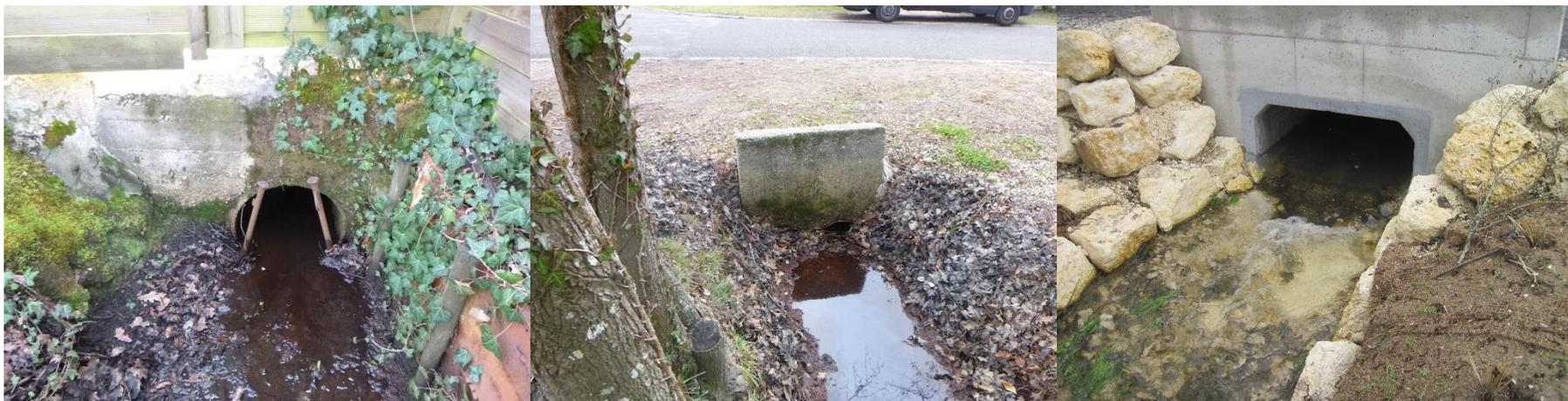
Photo 21 : Vue amont des buses à remplacer, et exemple de dalot de remplacement
