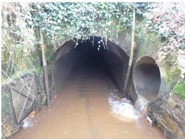
*Photo 8 : Rejet industriel douteux, rejet domestique, rejets d'eau pluviale*
