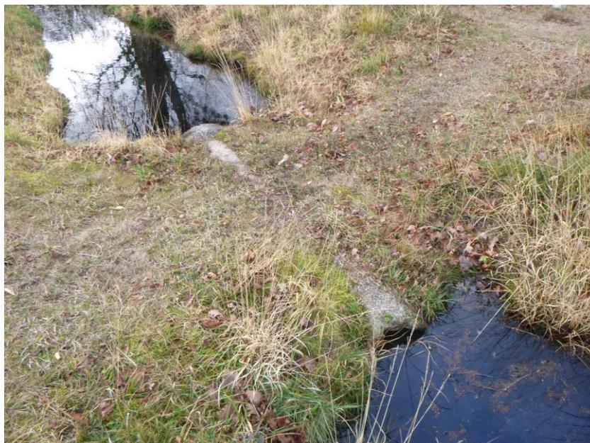
*Photo 4 : Exemple d’une buse sous dimensionnée*
