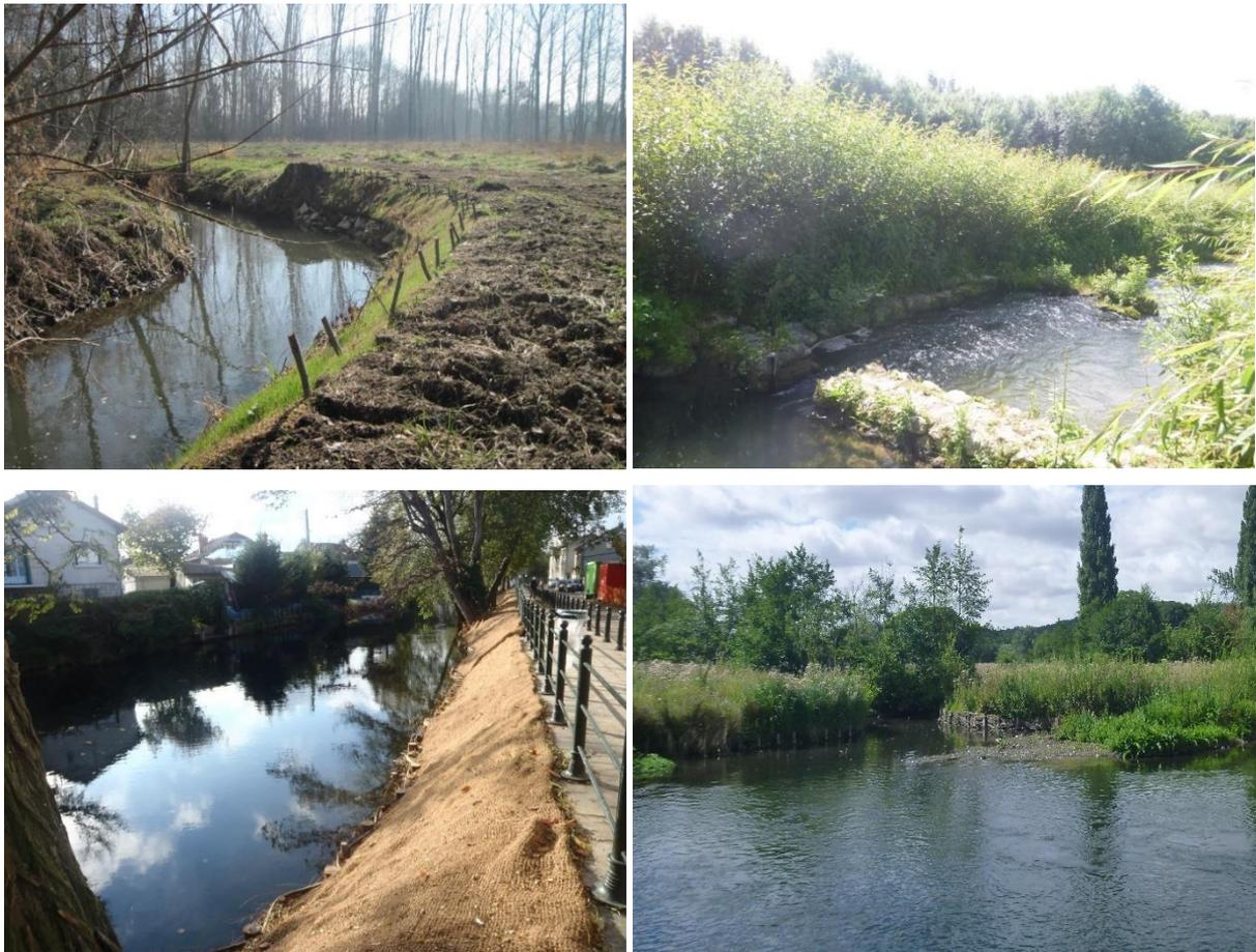
*Photo 7 : Exemples de protections de berges en technique mixte et végétale*
