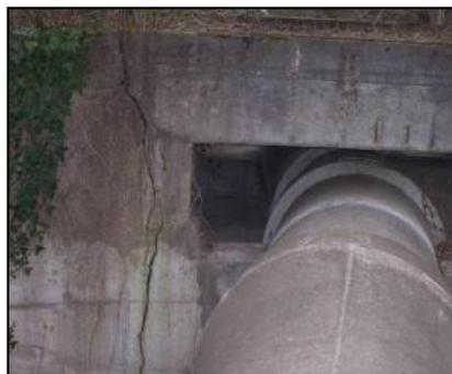
Nous avons mis en place des témoins au niveau du pont cadre courant 2022 afin de réaliser le suivi. L'usine Smurfit à réaliser la consolidation du pont cadre.
