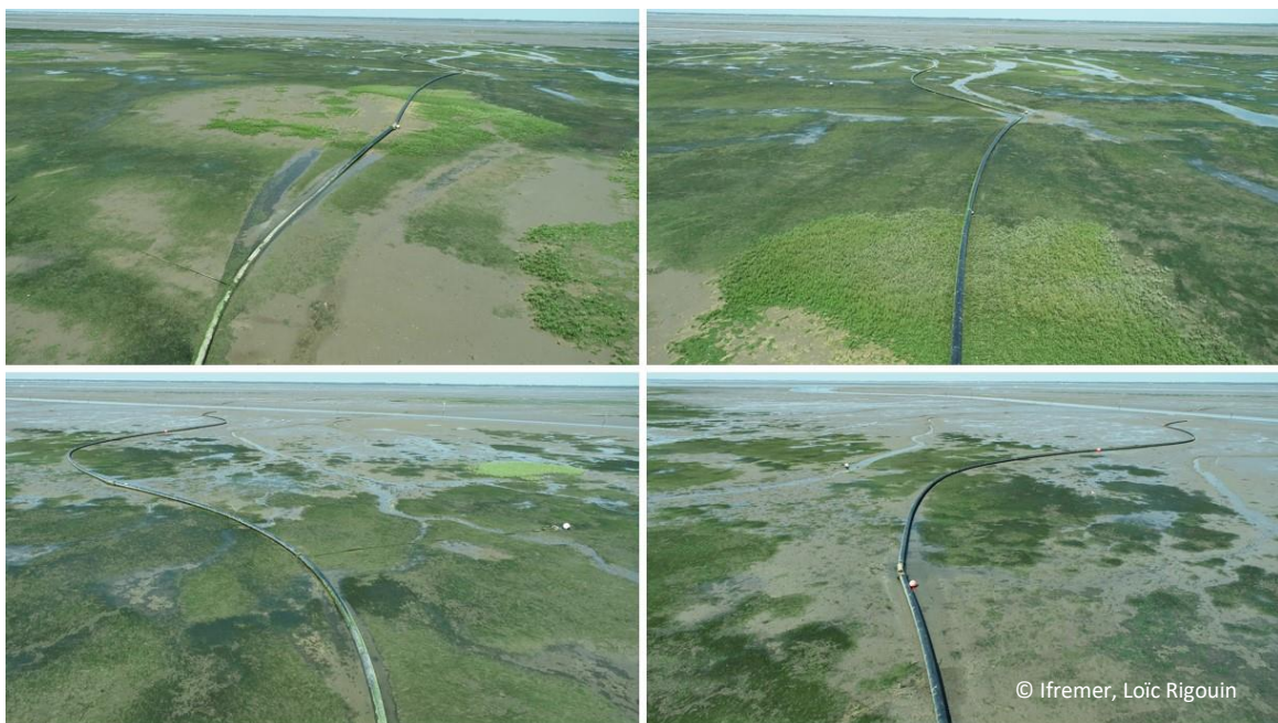
Figure 19 : Extrait des vidéos montrant les conduites de refoulement reposant en partie sur de l'herbier.
