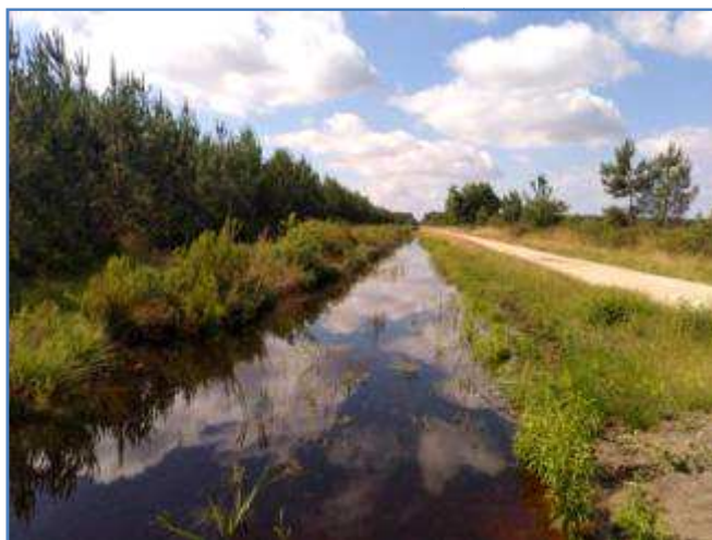
Figure 5 : portion coupée du canal de Canteranne dans le cadre de la construction du bassin de Canteranne, juin 2021
