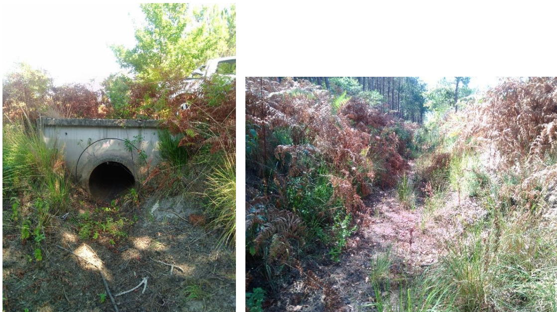
Figure 6 : Photos du tronçon 2 – source NCA Environnement
