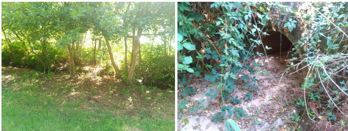
Figure 8 : Photos du tronçon 3 – source NCA Environnement
