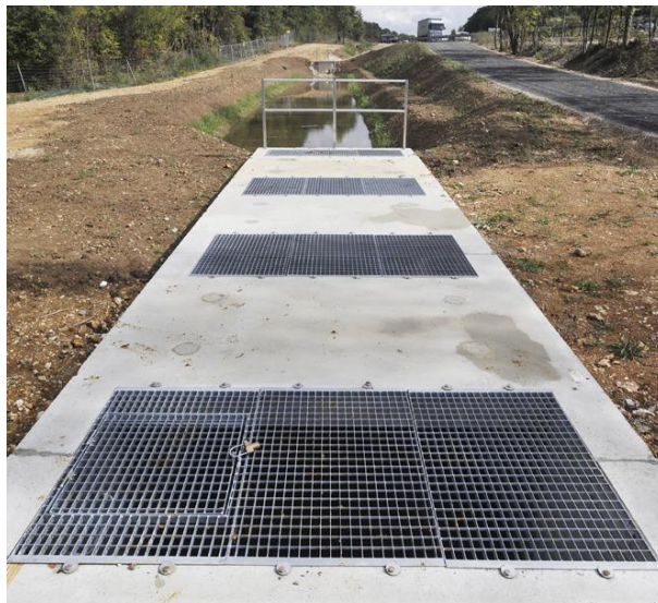
Photo 23 : Exemple d'ouvrage avec puits de jour (Cofiroute)
