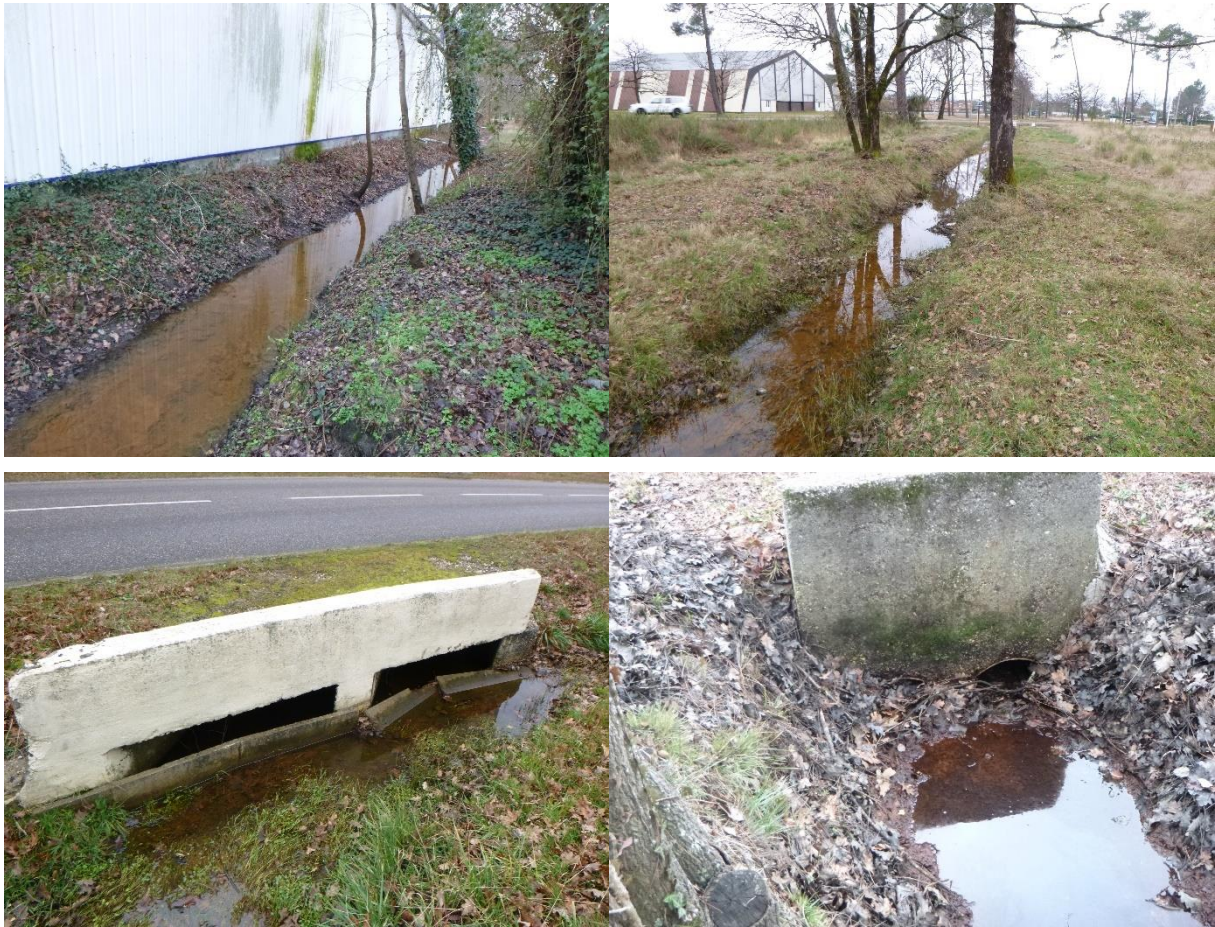
Photo 15 : Fossé du Pont biais
