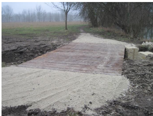
Photo 22 : Exemple de passerelle en bois
