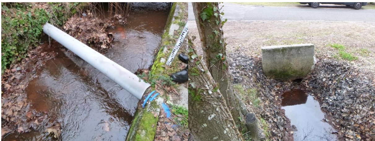
Photo 18 : Conduite et ouvrage limitant
