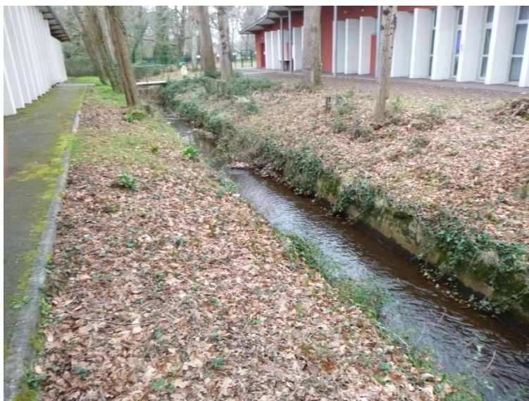
Photo 17 : Secteur du lycée et proximité des bâtiments
