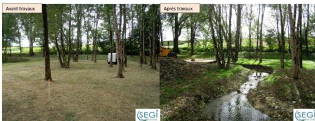
Photo 19 : Exemple de travaux de reméandrage
