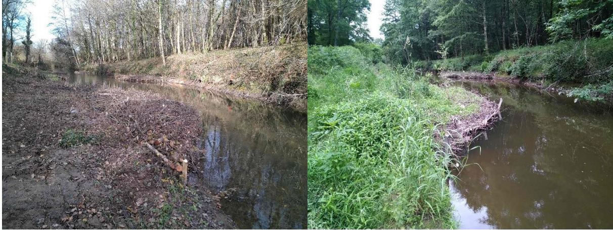
Photo 1 : Banquettes végétales sur la Charente amont (MOE SEGI)
