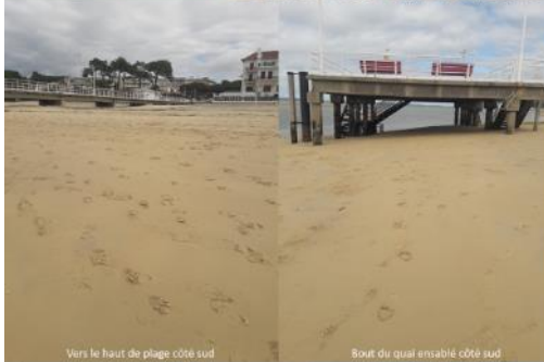
Vers le haut de plage côté sud
