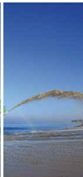
Opération de réensablement des plages du Pyla (Drague Mélina - SDI)
