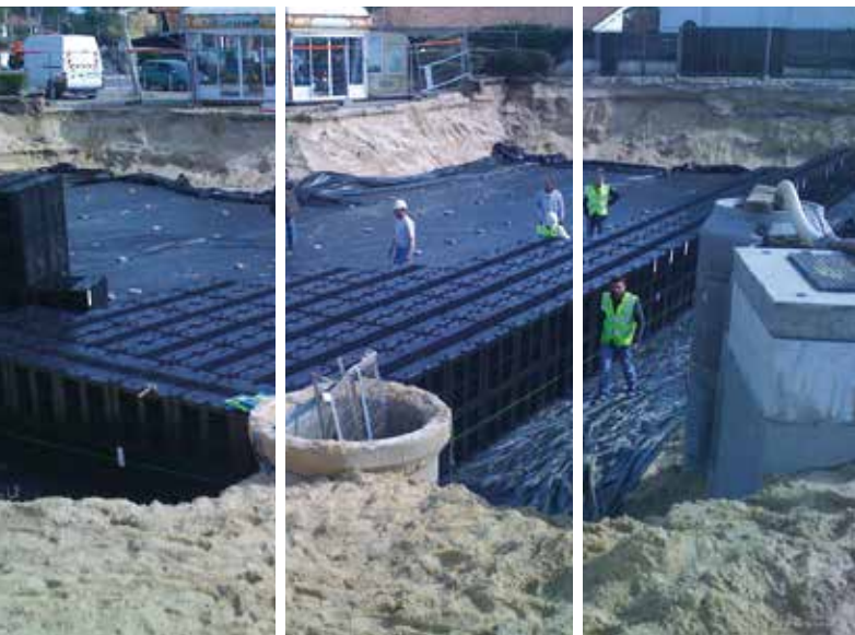
Exemple de chantier de création de bassins enterrés de stockage et d'infiltration des eaux pluviales au Cap Ferret et à Pyla sur mer
