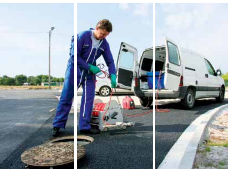
Contrôle du réseau d'assainissement
