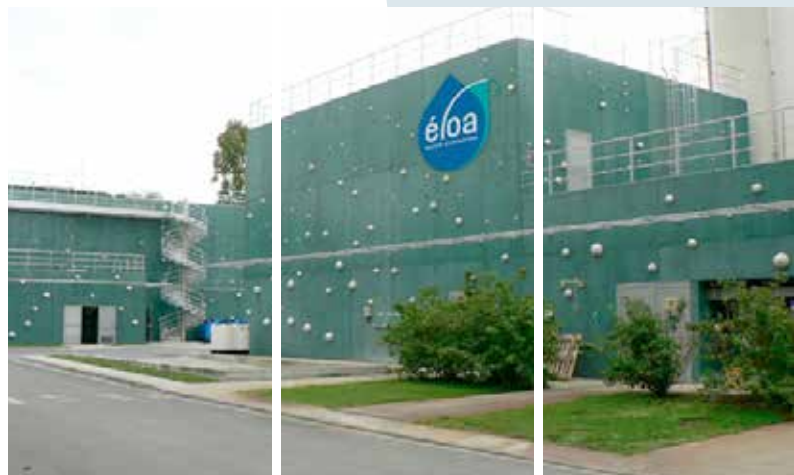
Stations d'épuration de La Teste de Buch et de Biganos construites à l'identique en 2007. La construction de ces 2 stations d'épuration a représenté un coût financier important pour la collectivité : 40 millions d'euros.
